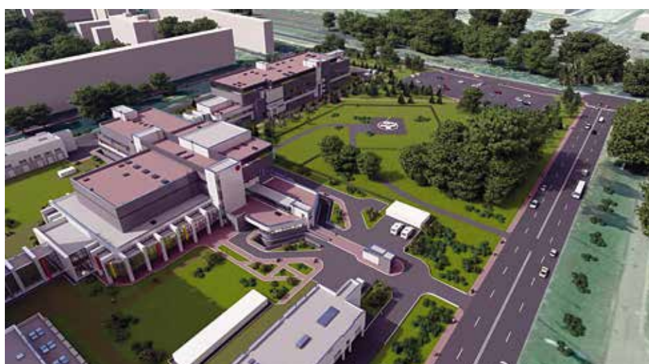
Строительство нового корпуса СПб НИИ скорой помощи им. И.И. Джанелидзе — Центра неотложной хирургии (в структуре — стационарное отделение скорой медицинской помощи)
